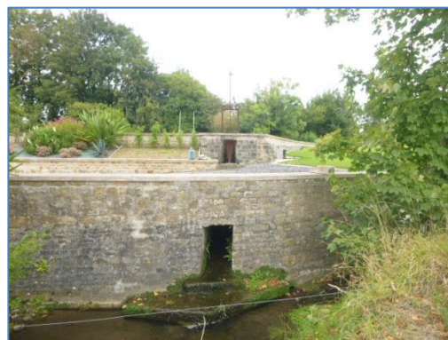
Vue de l'ouvrage de décharge aval.
