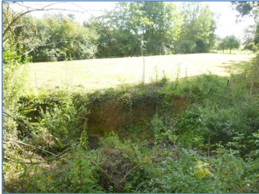
Vue du lit mis en bief avec une érosion régressive et des écoulements sur l'argile en aval.
