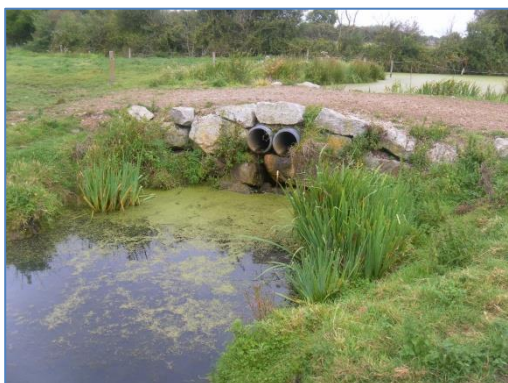
Vue du passage busé agricole présent en aval des Heutes.
